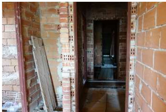
Podkroví chodba do bytu č. 3
