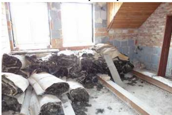
Podkroví pokoj v bytě č. 3
