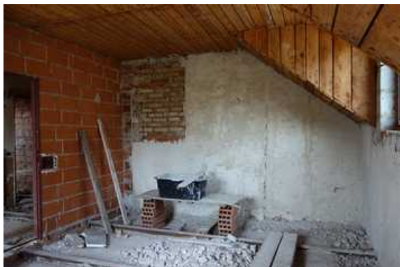
Podkroví - pokoj v bytě č. 1
