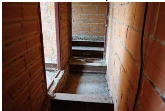
Podkroví chadba byt č. 3
