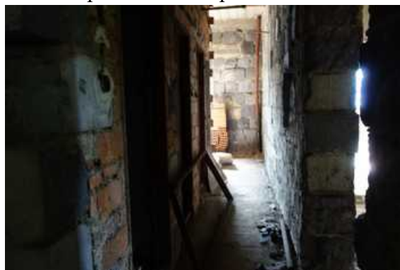
1. NP chodba do šatny
